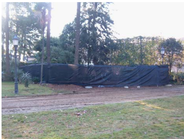
FOTO 11. Protecció del sector 2
