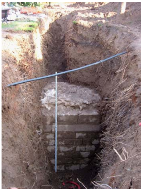
FOTO 5. Vista general del sondeig 1, una vegada ampliat. En primer terme l'estructura UE 8. Part oriental
