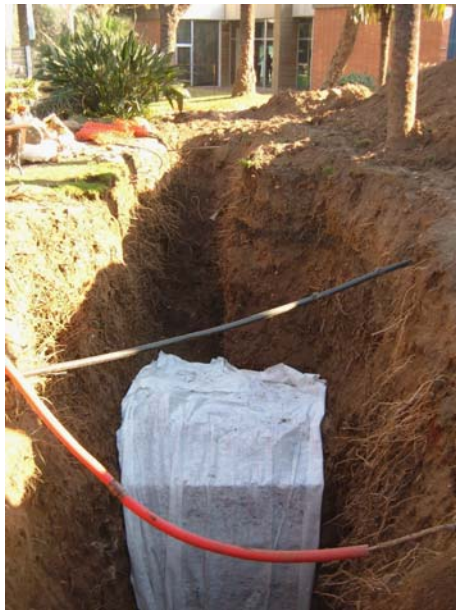
FOTO 9. Protecció de les restes amb geotèxtil
